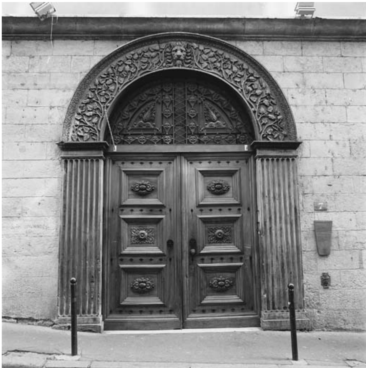
Entrée principale, vue ouest
