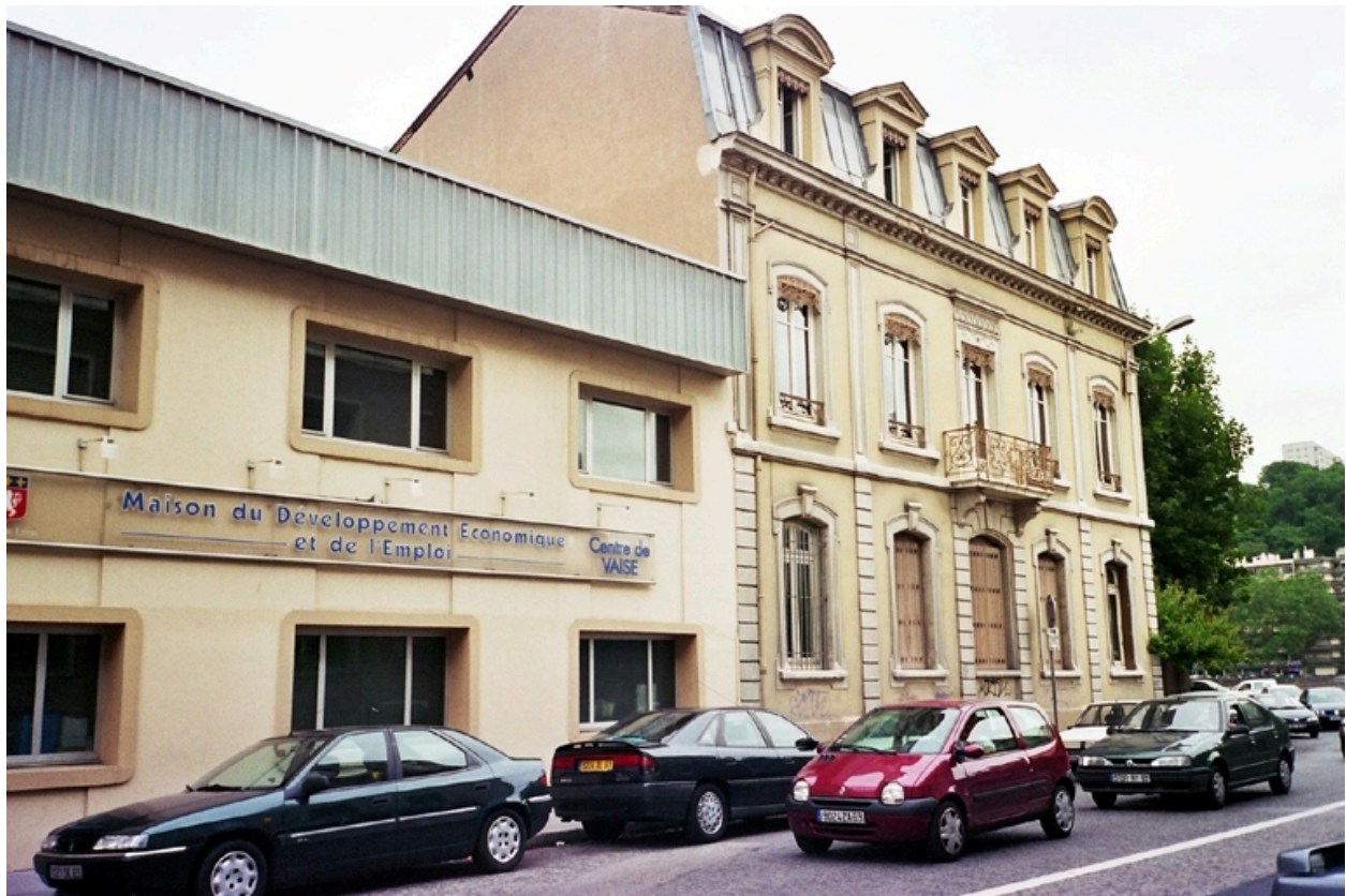
Vue du bâtiment de l'ANPE qui va être démoli
