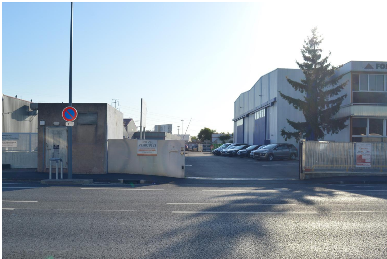
Entreprise Foselev Agintis - vue depuis l'avenue Francis de Pressensé - mai 2022
