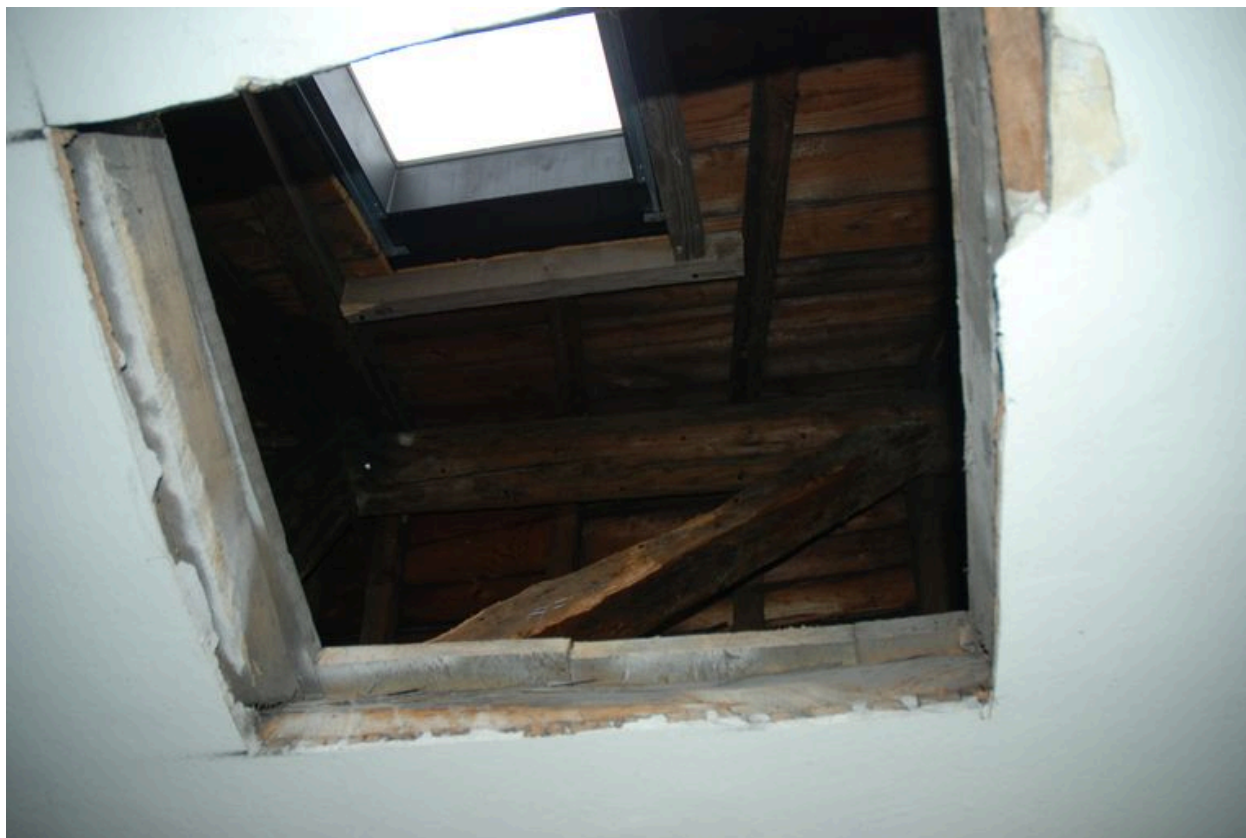
Vue de l'accès à la charpente
