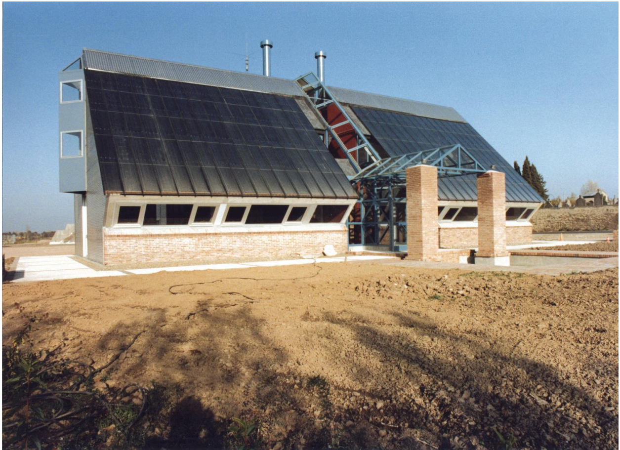
Billom, subdivision de la DDE, le corps de bâtiment sud vu du sud-ouest, état initial, 1983, archives privées J.-P. Reuillard.
