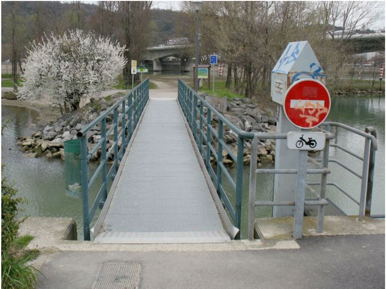
Vue sur l'ouvrage
