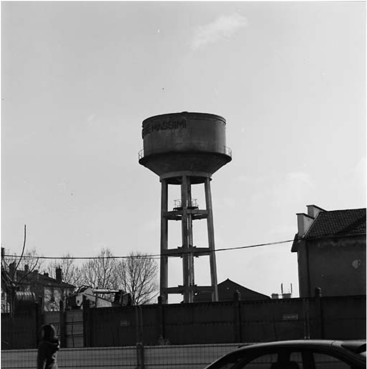
Château d'eau avec enseigne, vue sud-ouest
