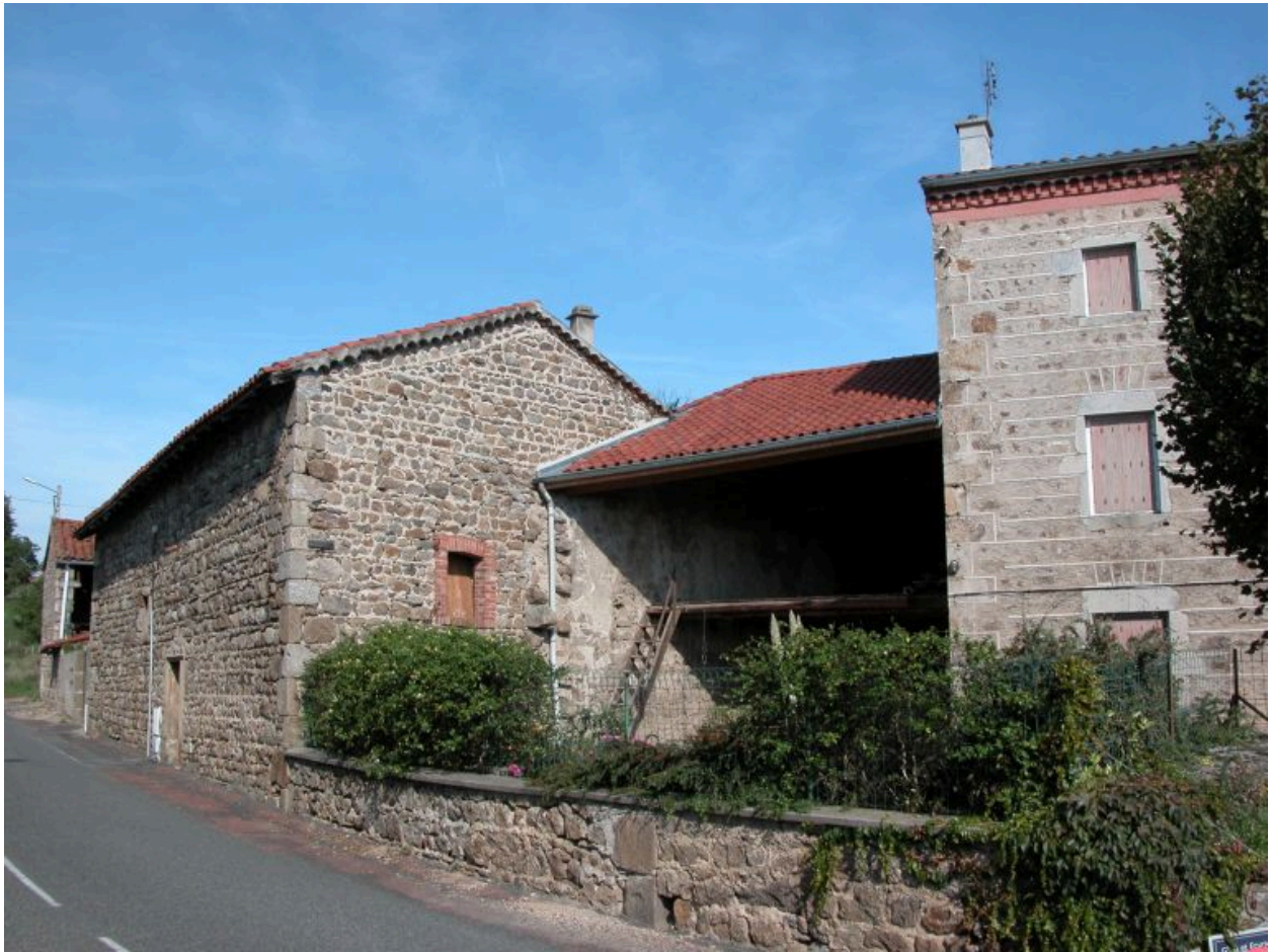
Vue d'ensemble du logis avec la grange-étable.
