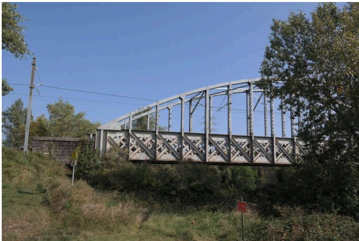
Pont ferroviaire de Vongy, détail rive gauche
