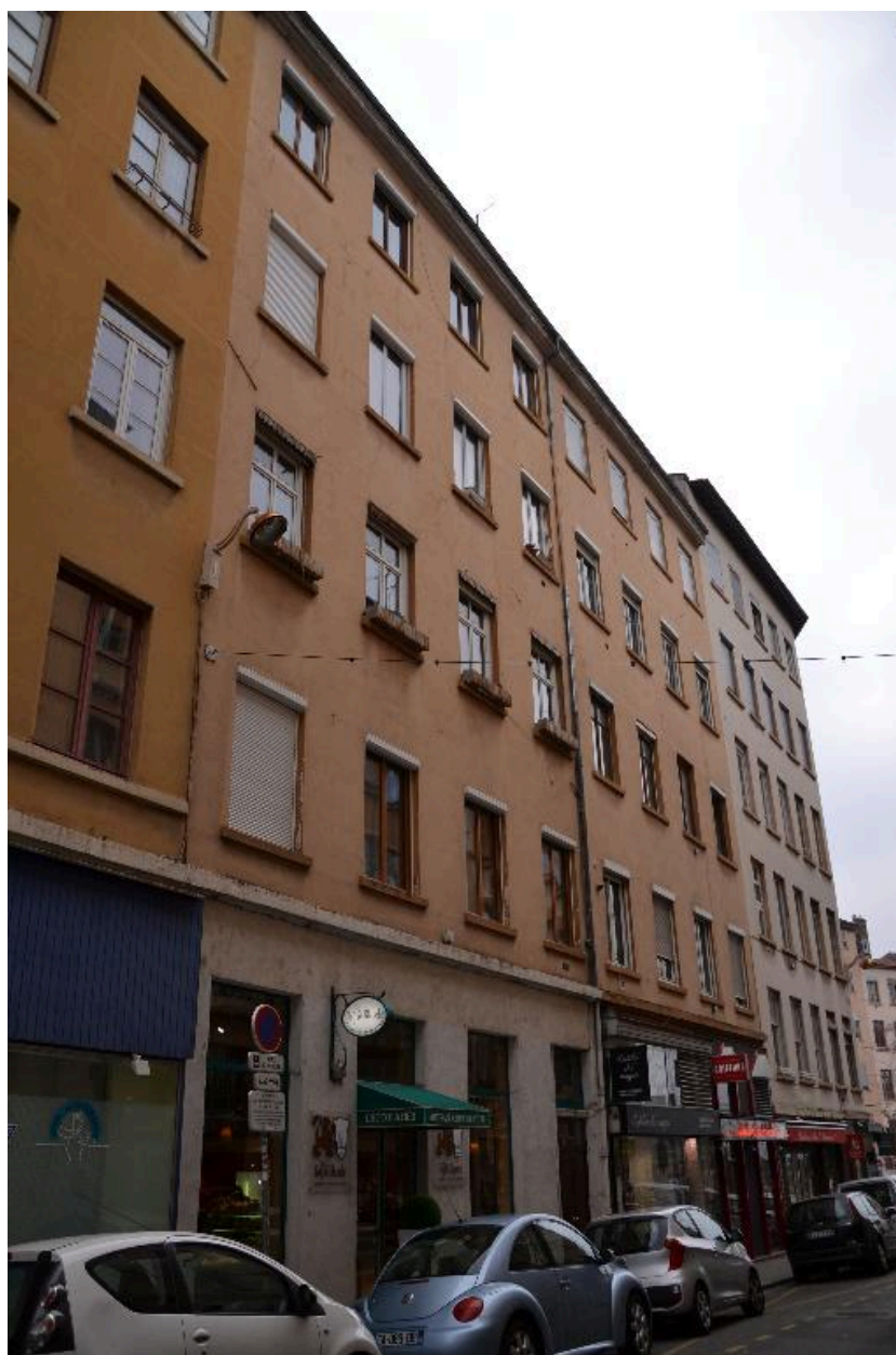
Vue d'ensemble façade sud
