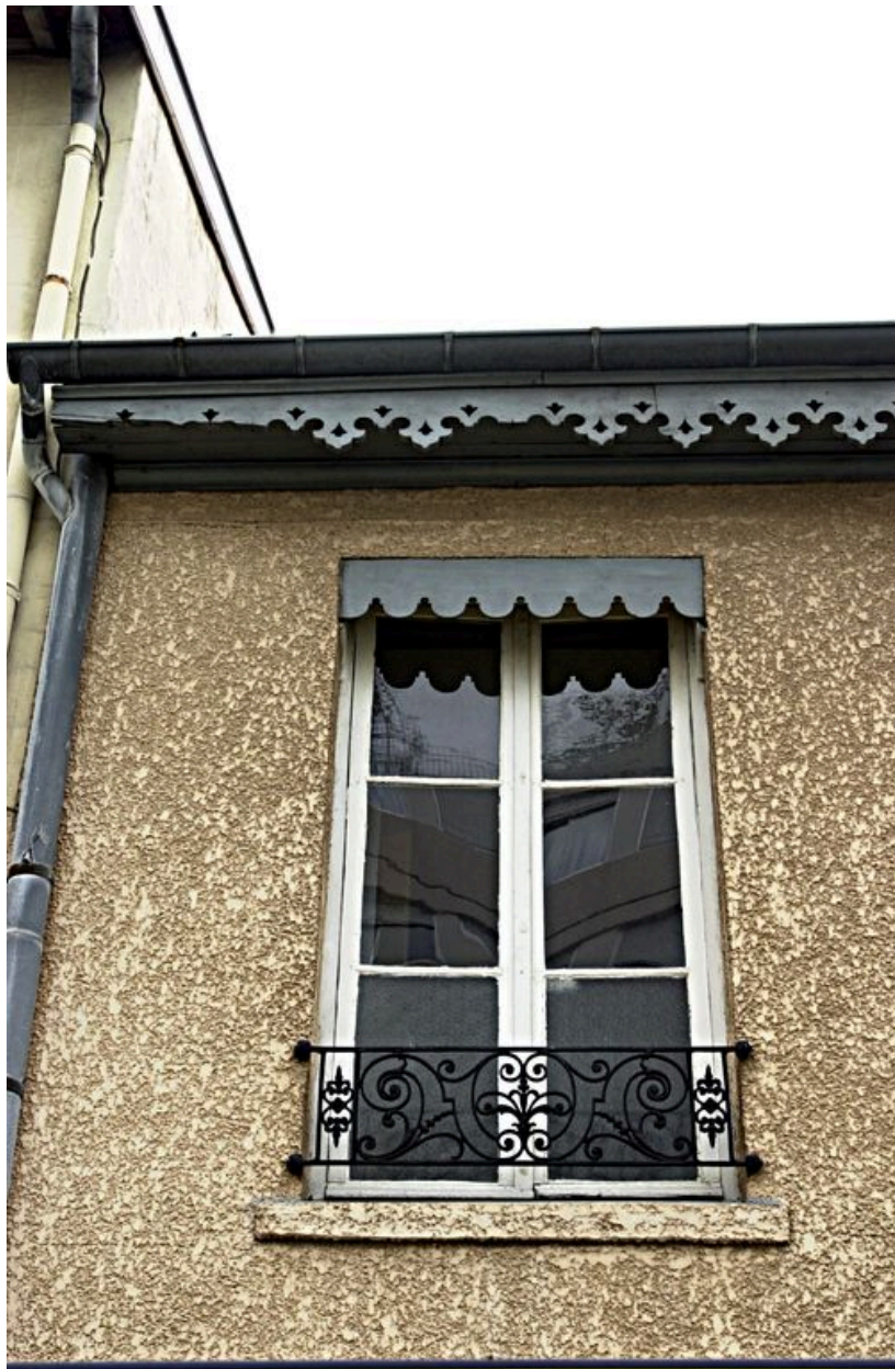
Façade sur rue, détail de la fenêtre gauche au premier étage
