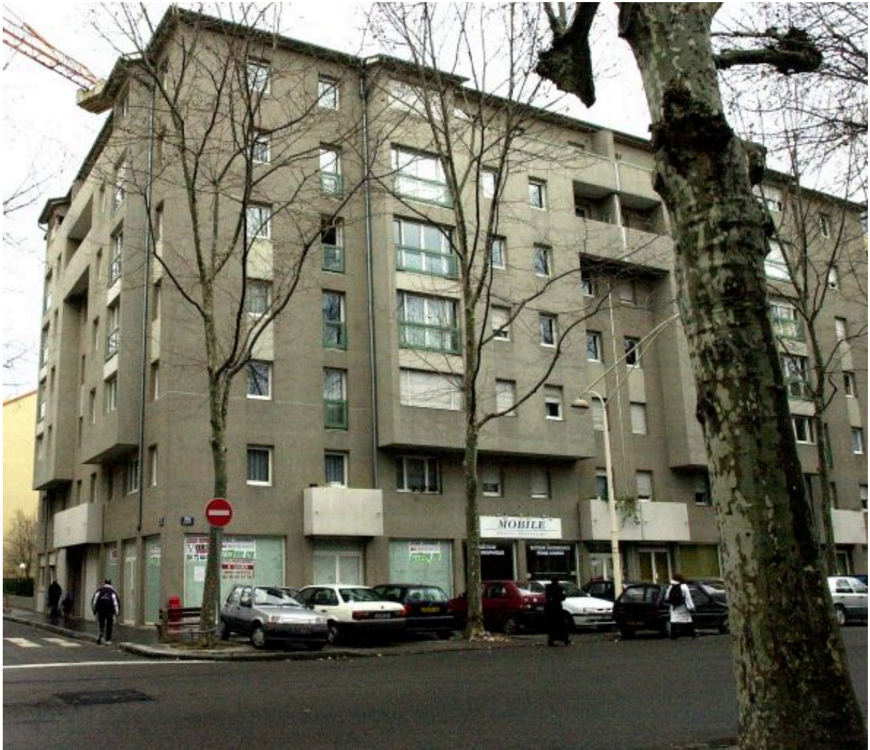
Élévation, rue Quivogne, à l'angle du cours Suchet
