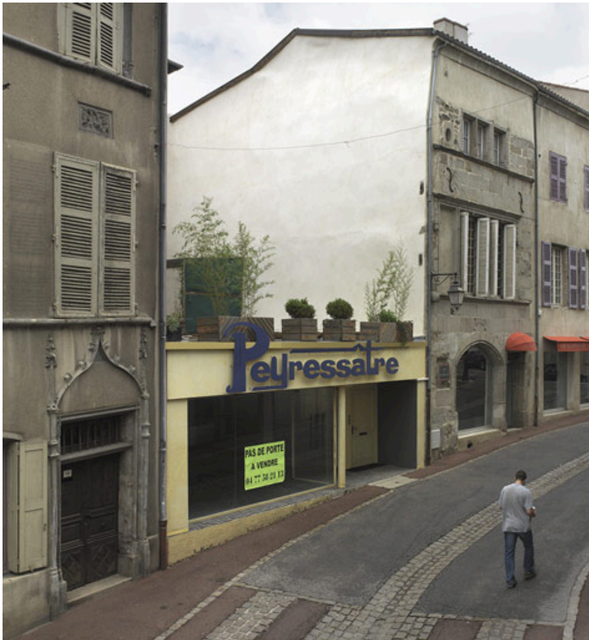
Local commercial à l'emplacement de l'hôtel du côté de la rue Saint-Pierre.
