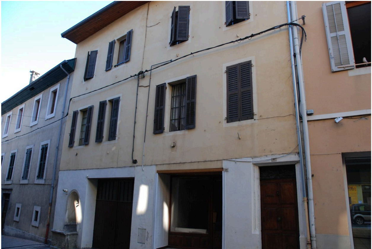
Maison, immeuble, 107, 109 rue Louis Blanc-Pinget (2018 E1 1230). Elévation sur rue.
