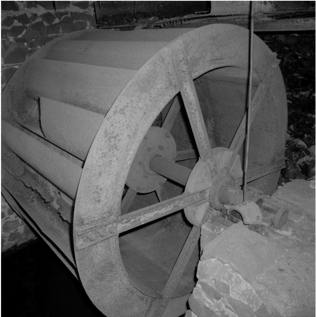
Vue d'ensemble de la roue hydraulique métallique.
