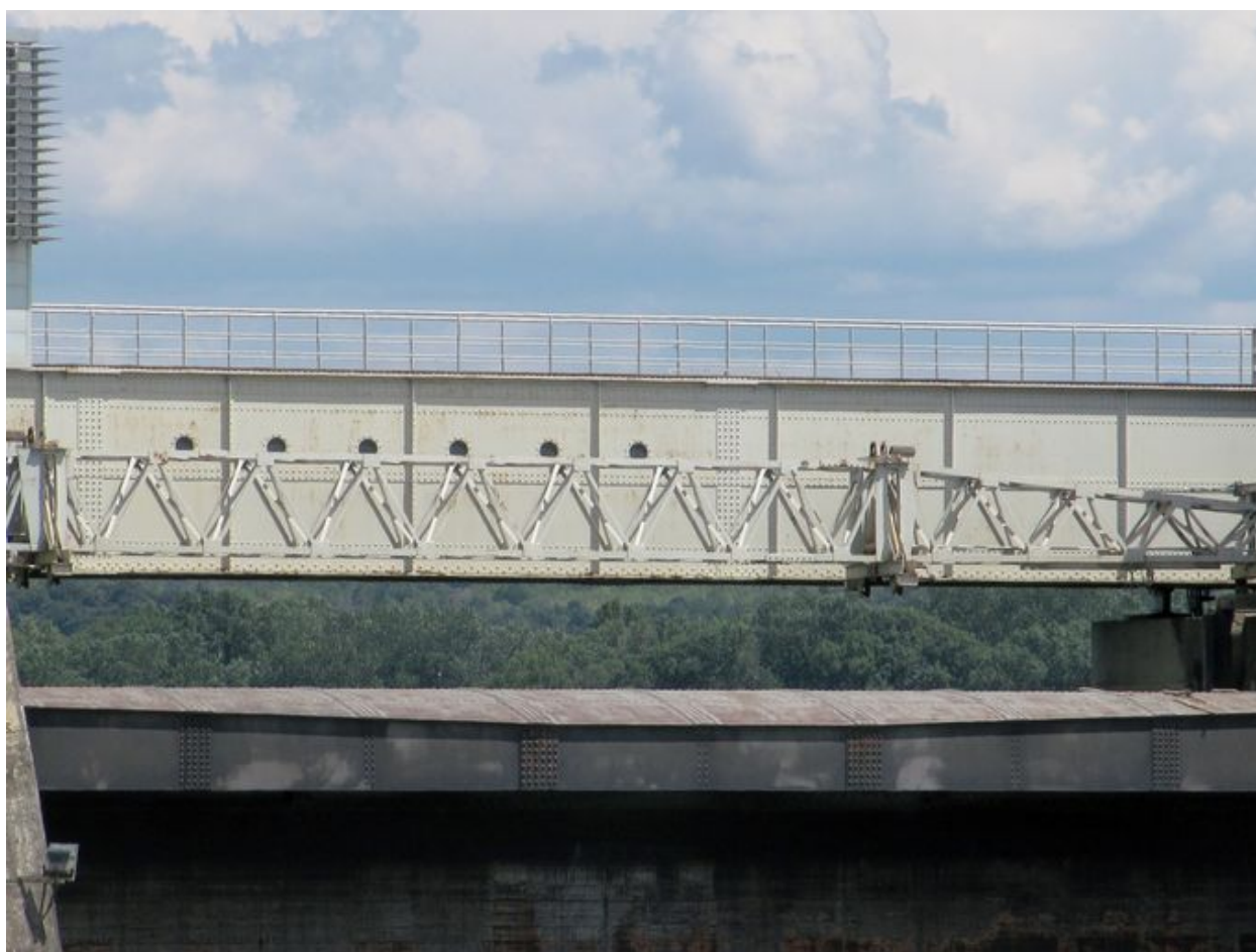
Détail du pont de service, vue partielle face aval
