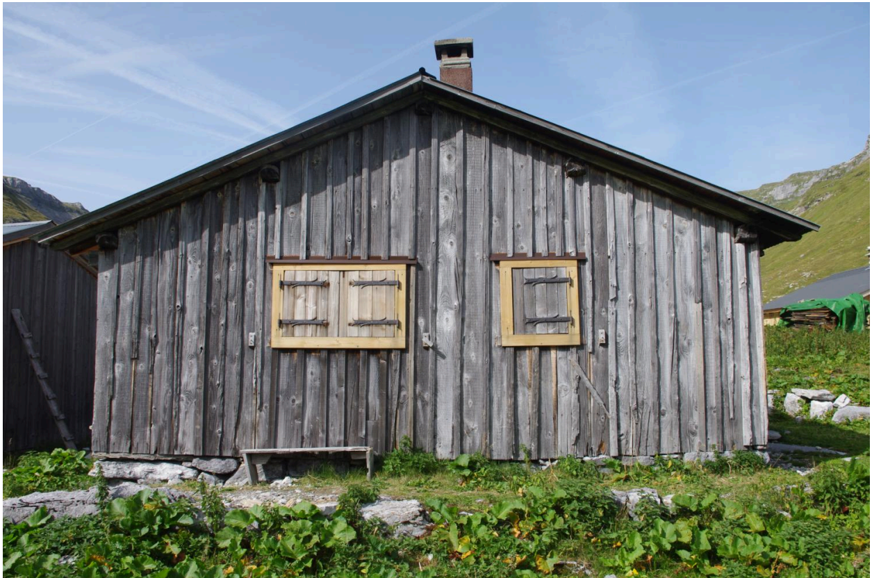
Vue du mur pignon sud
