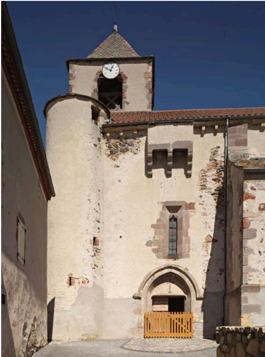
Vue de détail côté sud.
