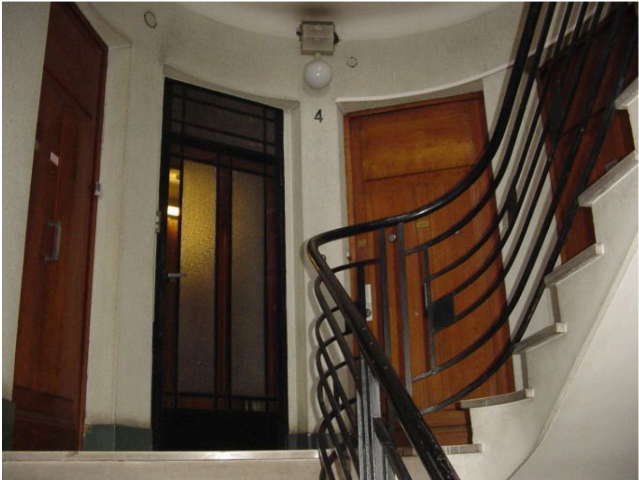
Portes palières et ascenseur
