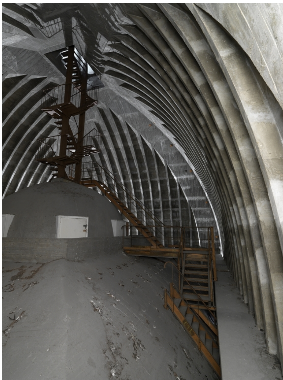
Le dôme Soufflot. La charpente en béton. Détail d'un arêtier
