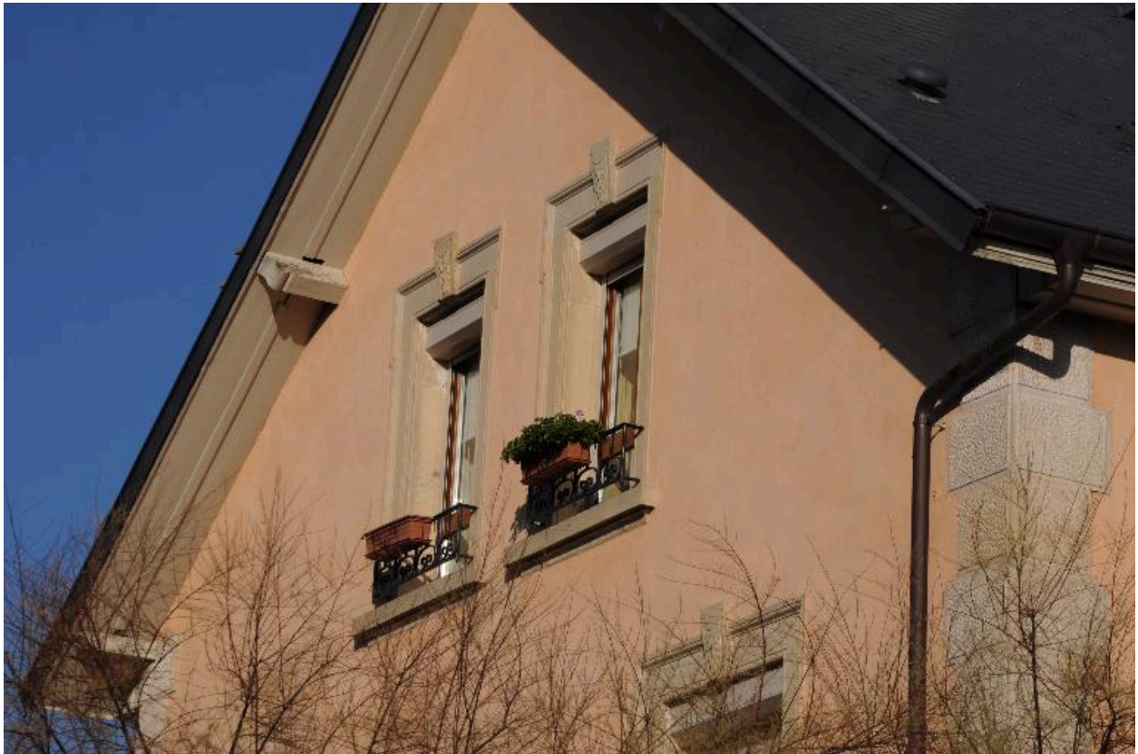
Baies du pignon ouest
