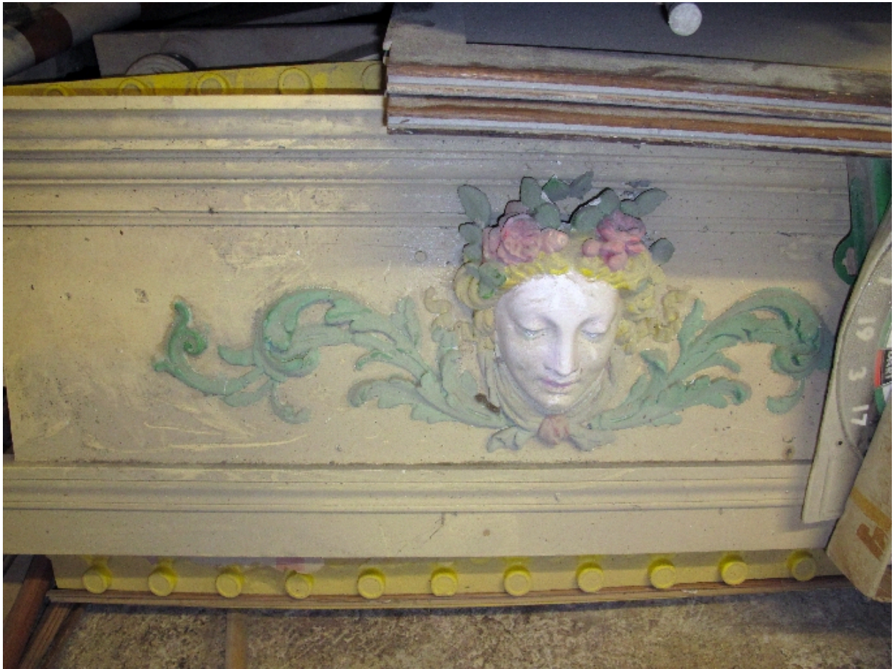
Décor en staff d'un dessus-de-fenêtre déposé
