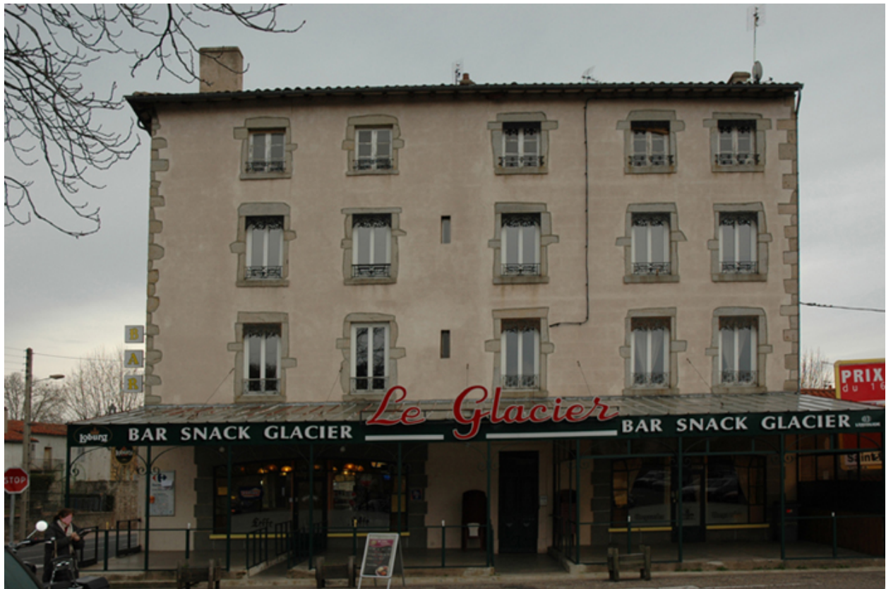
Vue générale depuis la place Bouvier.
