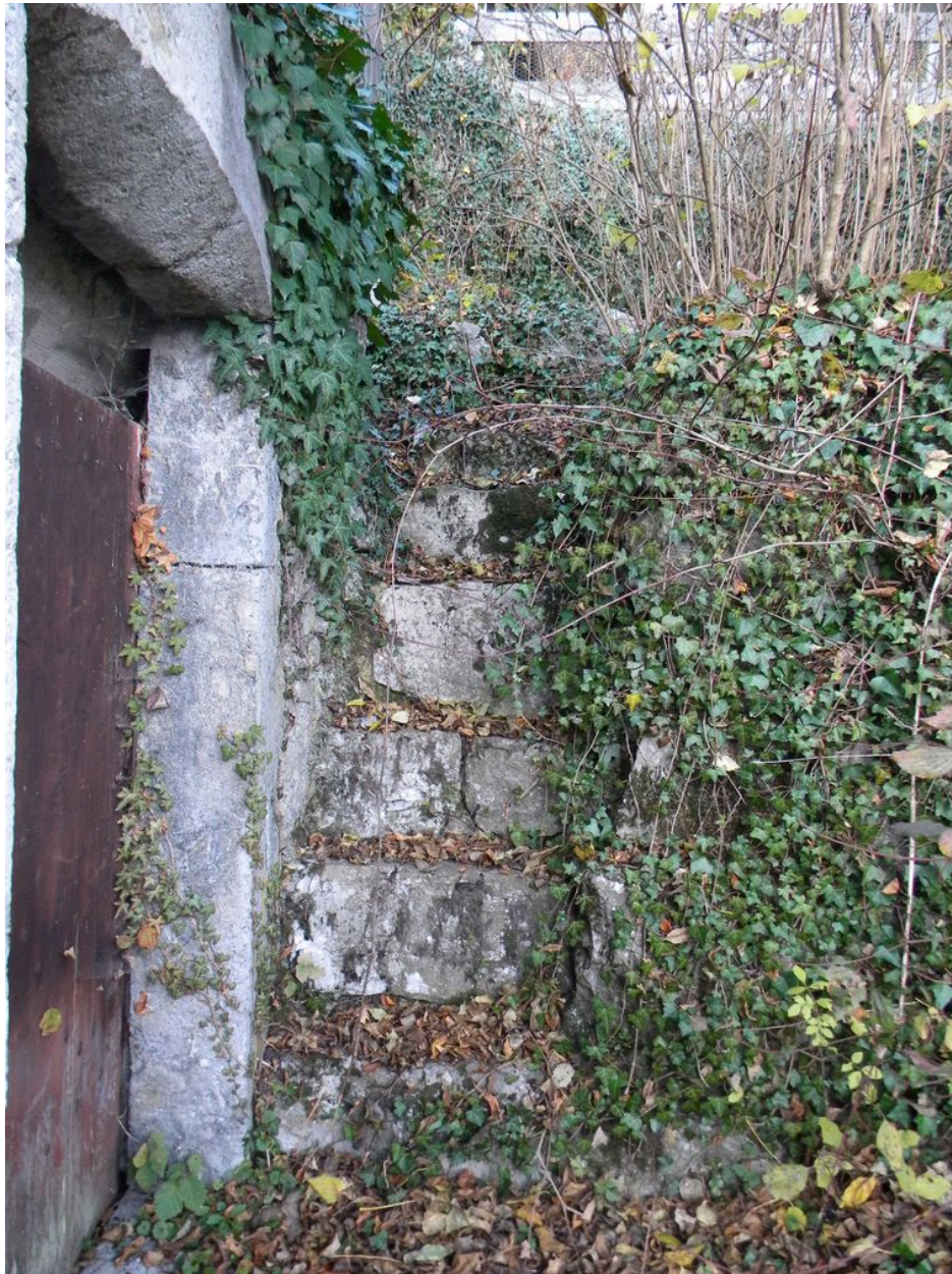
Vue d'un escalier établi dans le talus.
