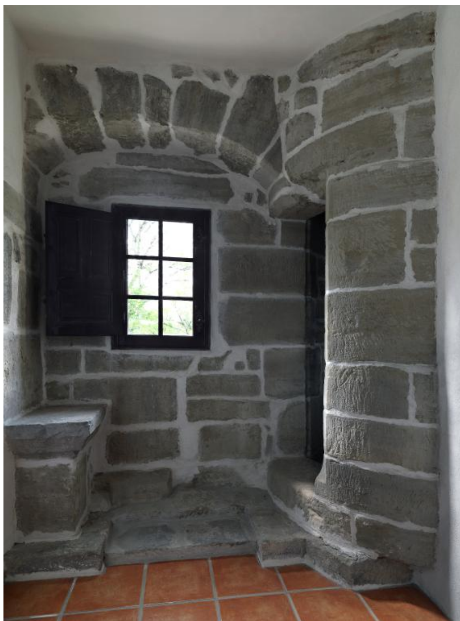
Vue d'ensemble intérieure de la tourelle nord au niveau de l'étage de comble de la maison forte.
