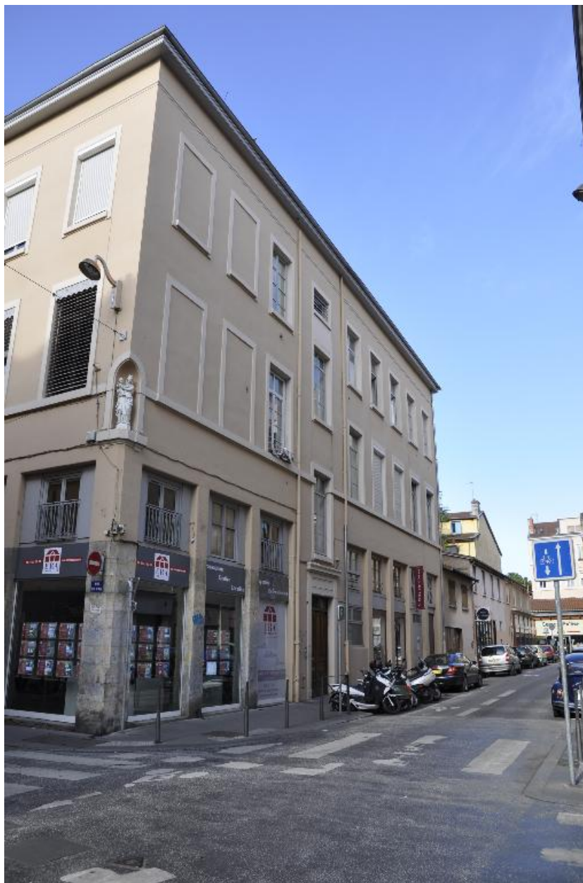
Vue nord est depuis la rue d'Ivry
