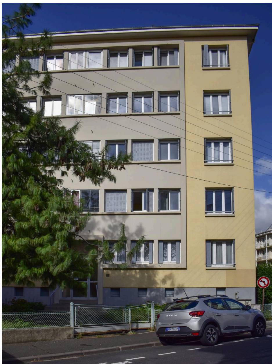
Façade sur la rue de Vallières
