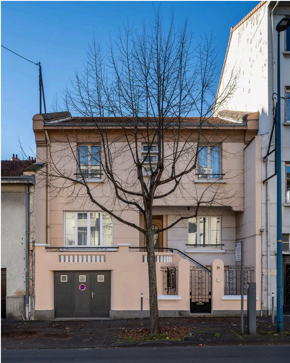
Façade sur le boulevard Jean-Jaurès
