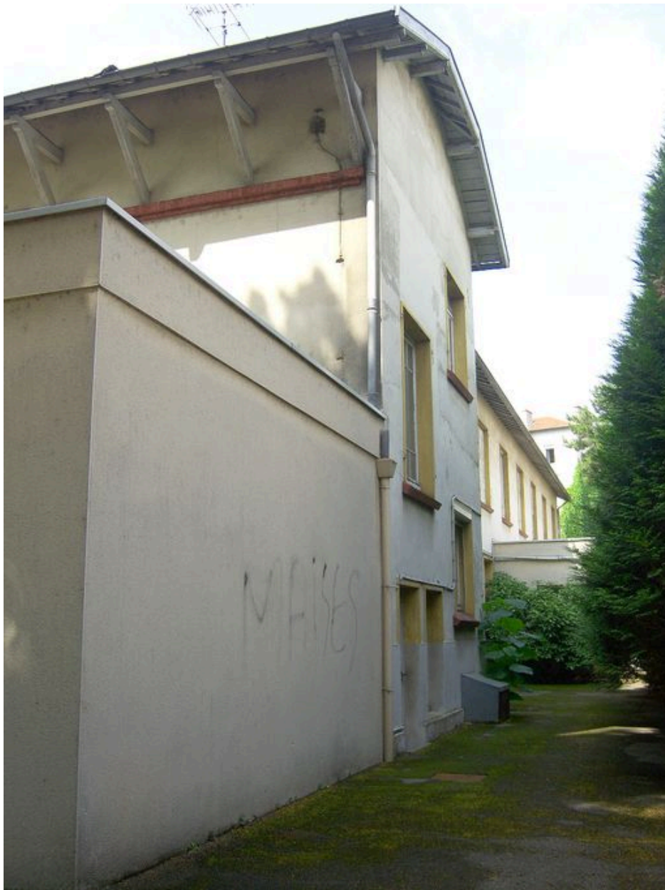
Bâtiment Nord Ouest, Élévation postérieure Nord
