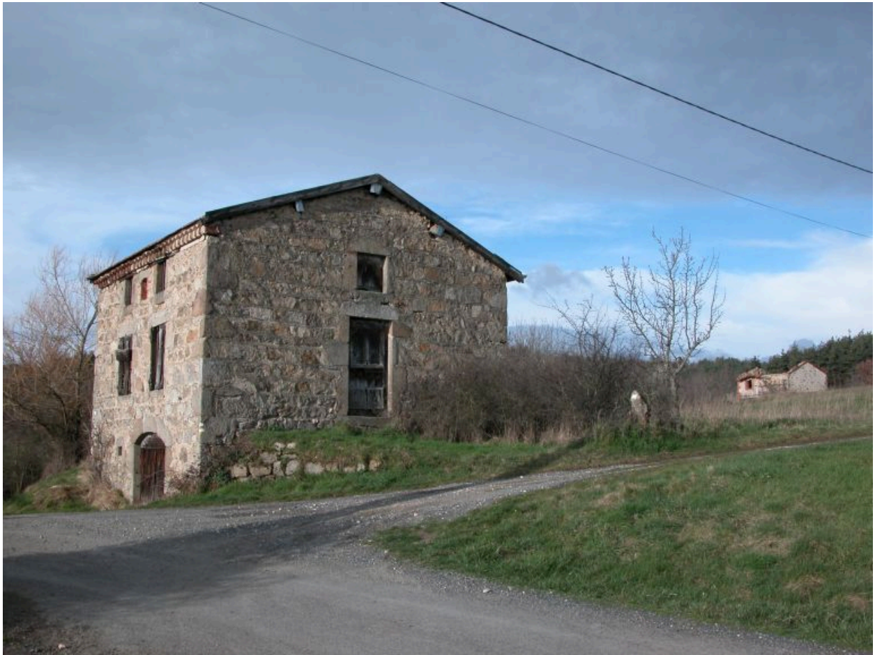
Vue d'ensemble de trois quarts avant droit du cuvage.
