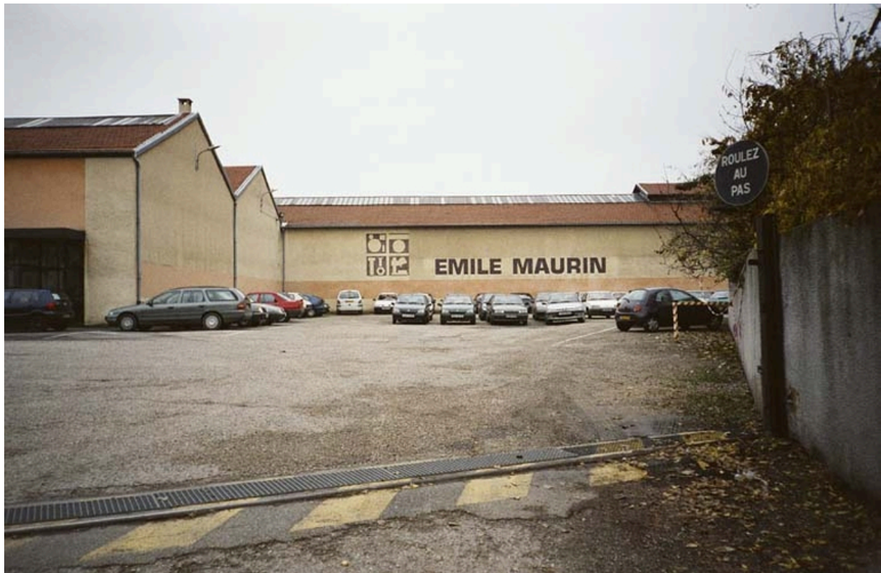
Vue est entrée livraison, enseigne
