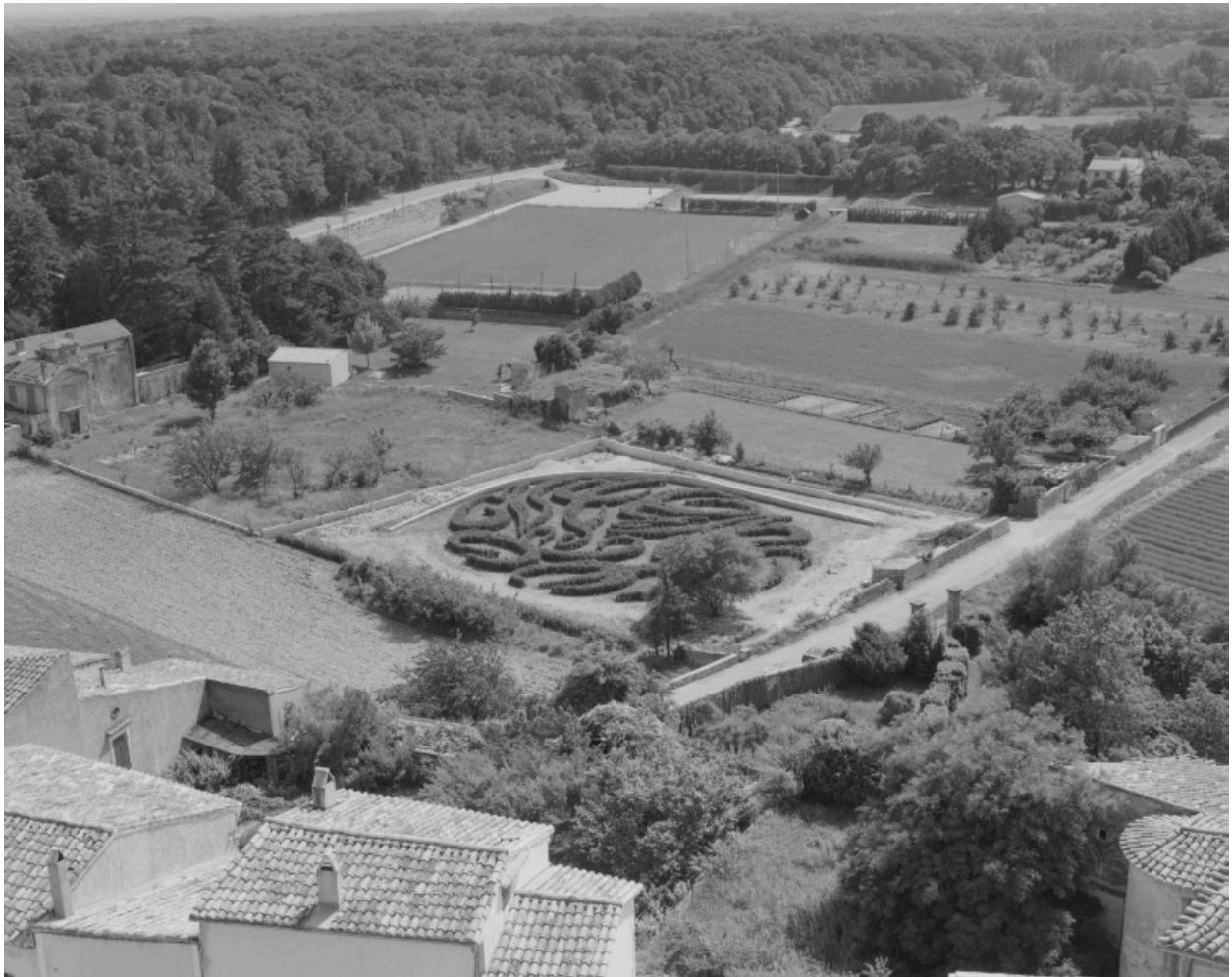
Vue des travaux de mise en place du jardin public : jardin de buis en cours de création. Vue prise depuis la terrasse du château.
