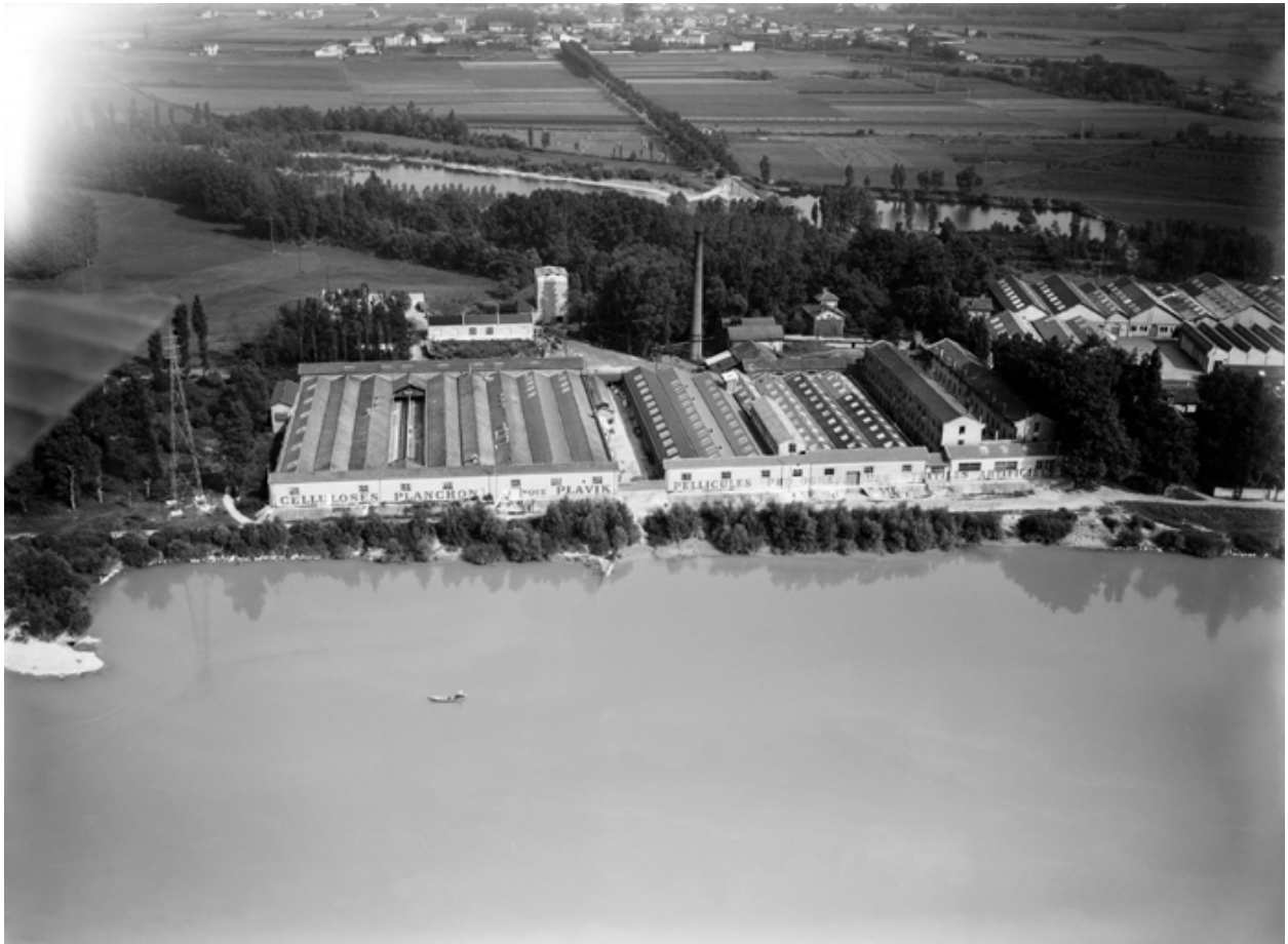
Vers 1920, vue aérienne des usines Planchon Feysin.
