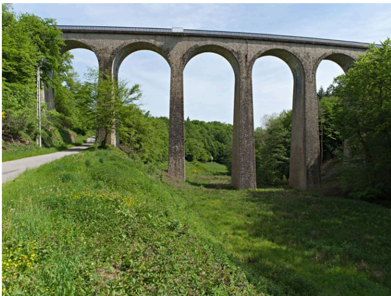
Vue générale du viaduc en contre-plongée.
