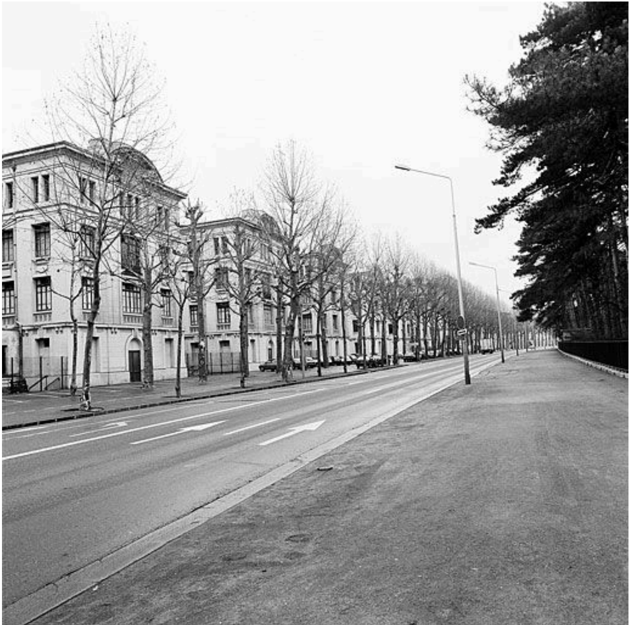
Vue générale du Palais de la Foire depuis le quai Achille-Lignon.
