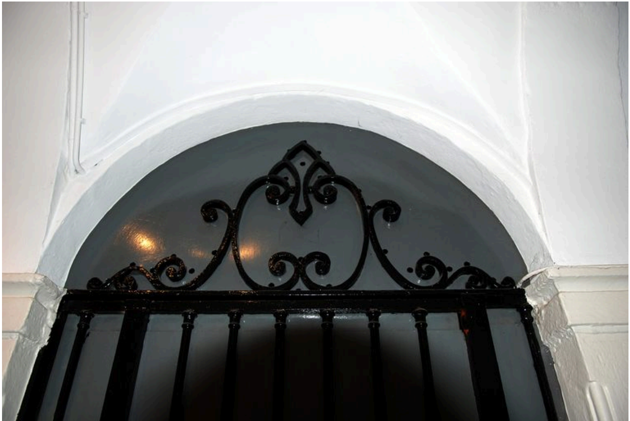
L'allée : détail d'une des grilles fermant l'accès à l'escalier
