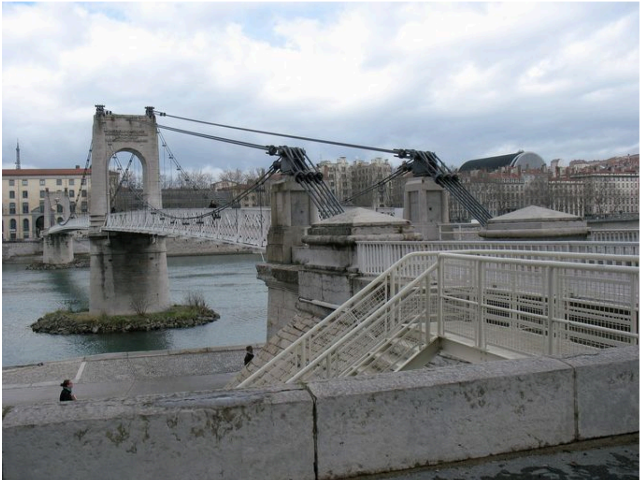
Vue côté aval (depuis la rive gauche)
