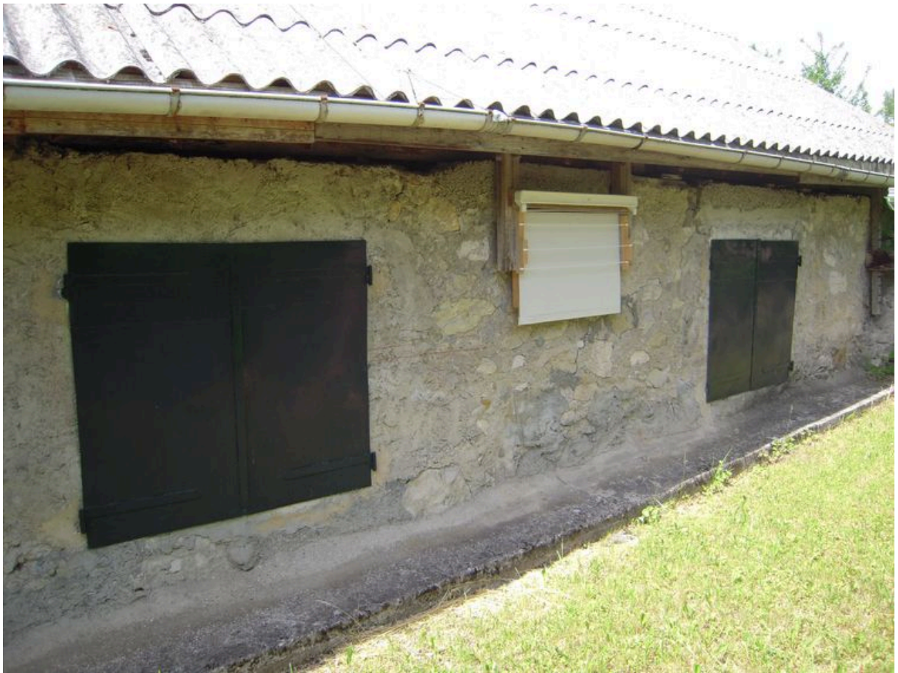
Vue de la façade est.
