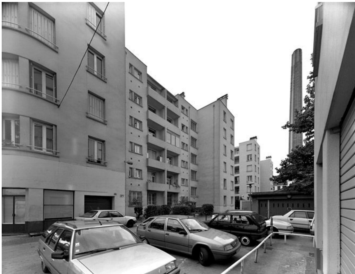
Elévation nord de l'immeuble 36-37 quai Perrache
