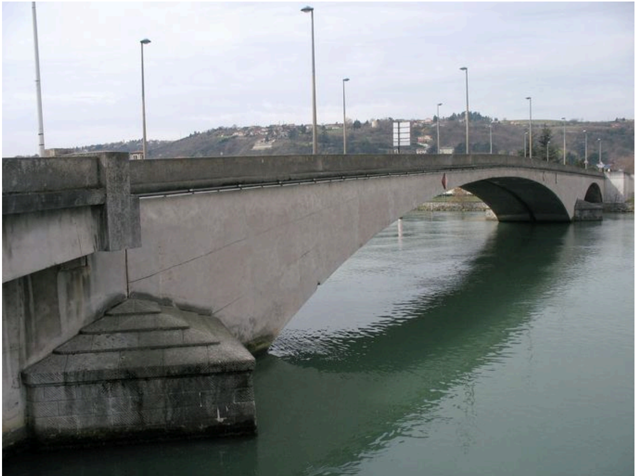
Vue du pont, côté amont (depuis la rive gauche)
