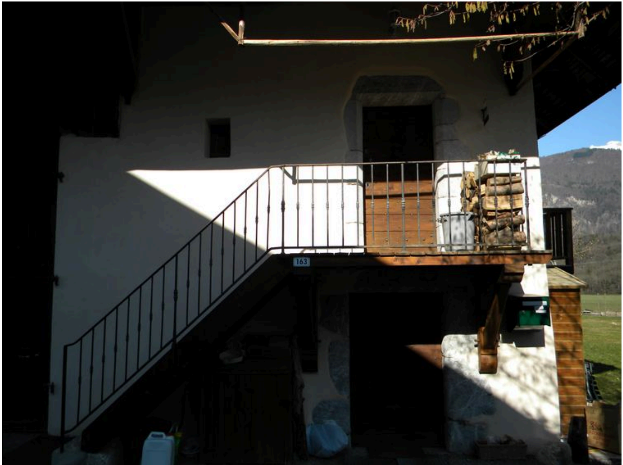
Escalier et porte d'entrée du logis ancien.
