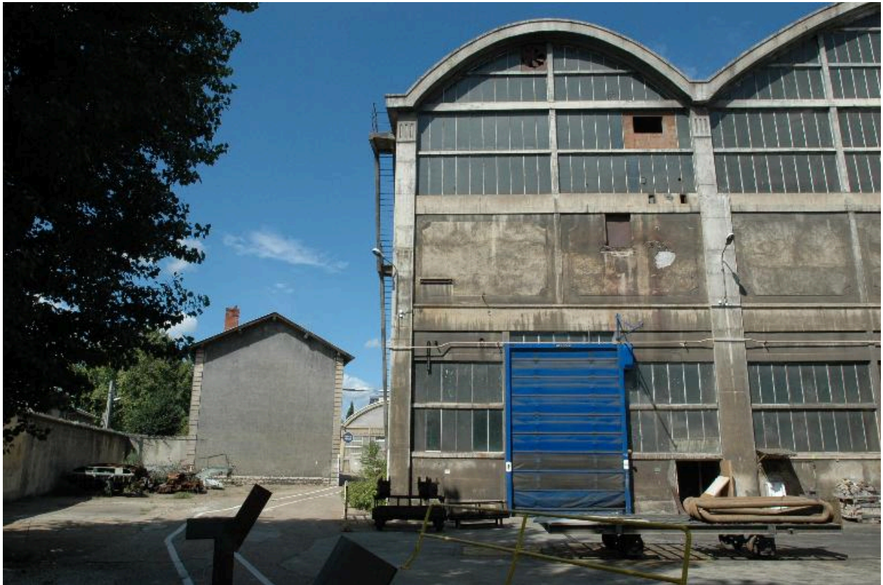
Vue extérieure des double halles
