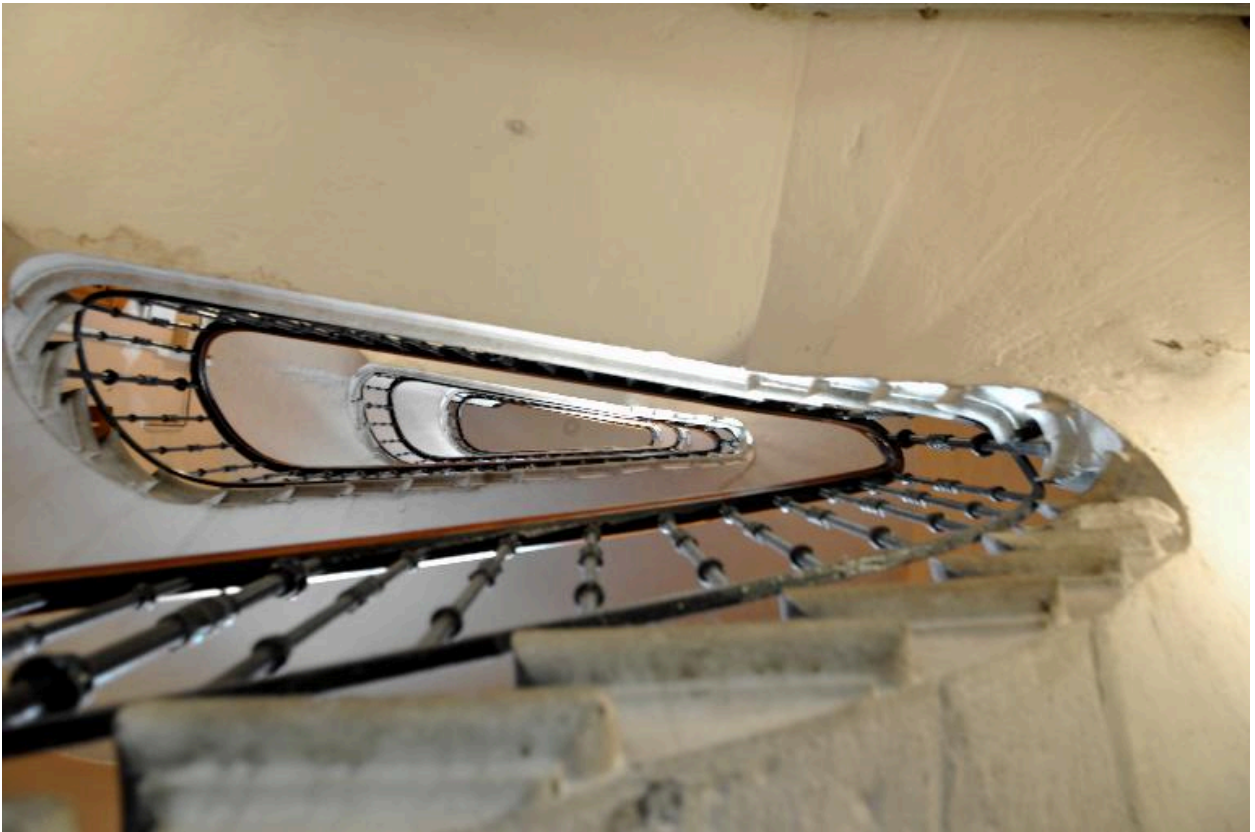
Vue intérieure, l'escalier
