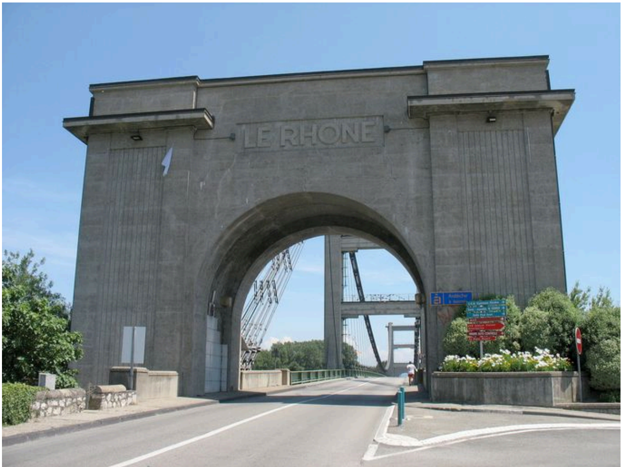
Arc monumental formant tête de pont sur la rive droite : vue générale, face nord-ouest
