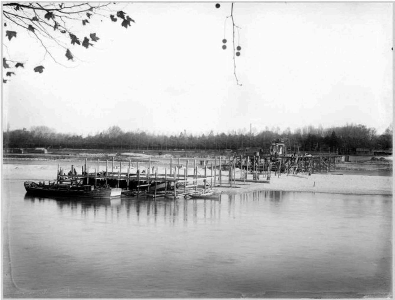
La construction du pont de la Boucle. Implantation des pieux. [1902]. 1 fotogr.: n. et b.
