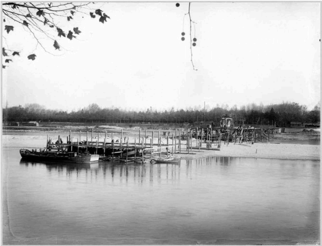
La construction du pont de la Boucle. Implantation des pieux. [1902]. 1 fotogr.: n. et b. (AM Lyon. 15 Ph 1802)
