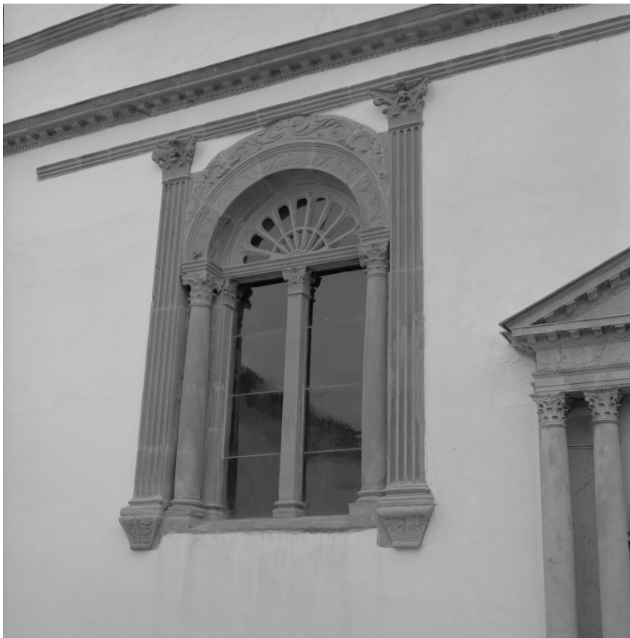
Vue générale de la fenêtre de la chapelle donnant sur la cour.
