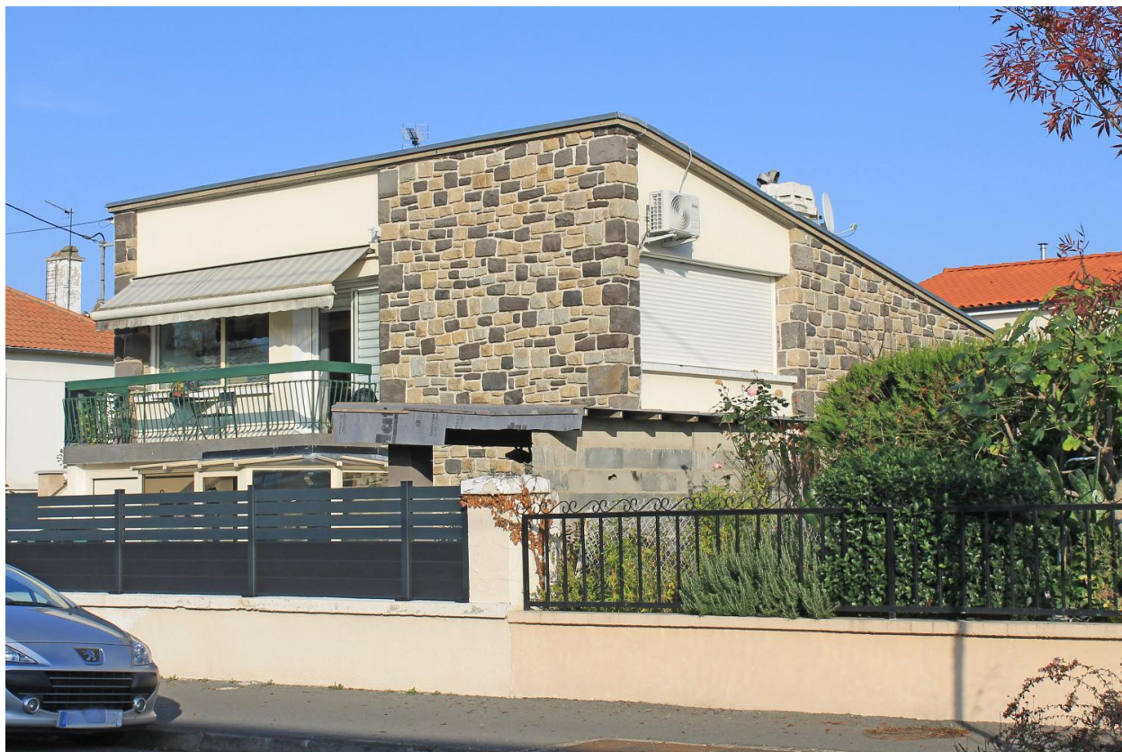
Gerzat, ma maison I.* vue du sud.
