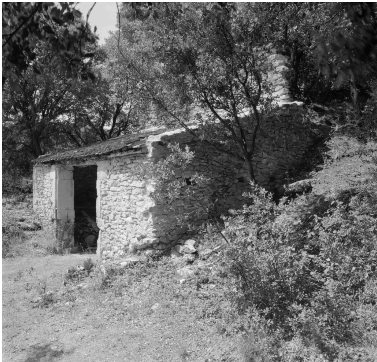
Vue latérale droite du four à chaux montrant le glacis
