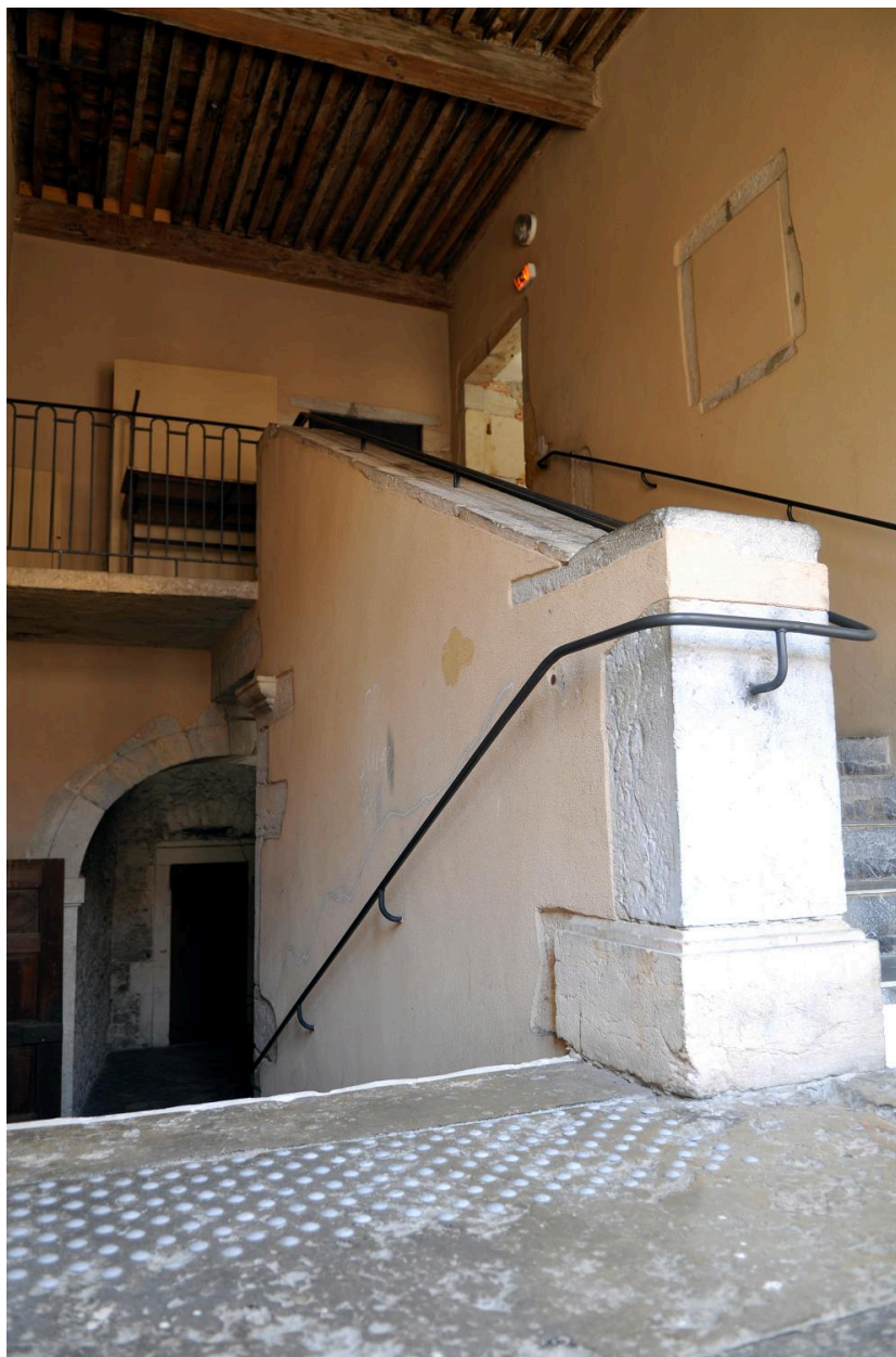
Bâtiment C : escalier G, dernière volée
