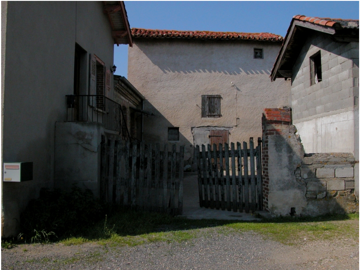
Vue depuis l'entrée de la cour.
